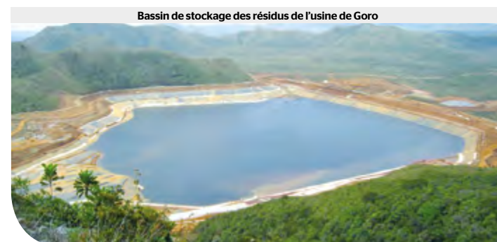
Bassin de stockage des résidus de l'usine de Goro
