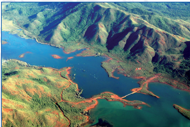
Vue aérienne du pont Pérignon dans le parc de la Rivière Bleue.
